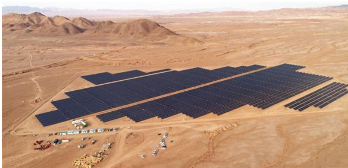
پروژه ۱۰ مگاواتی خوسف
